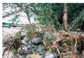
堤内への土砂流入の防止状況
