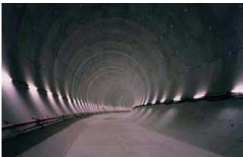
トンネル内部状況写真
