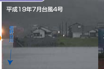
輪中堤完成後
