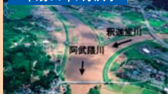
釈迦堂川合流点付近築堤（須賀川市）
