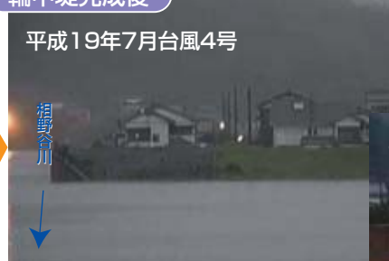
輪中堤完成後
