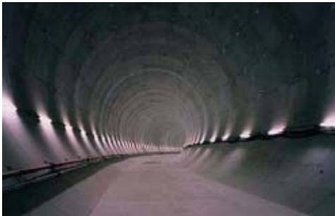
トンネル内部状況写真
