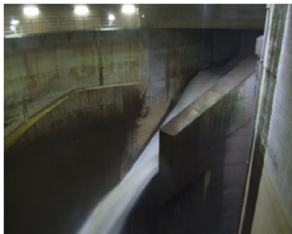
台風26号洪水時の流入する状況 (第3立坑)
