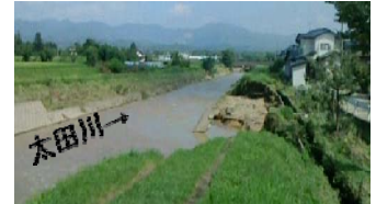
太田川 堤防決壊状況 (岩手県紫波町)
