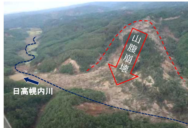
河道閉塞の状況（北海道厚真町幌内地区）
