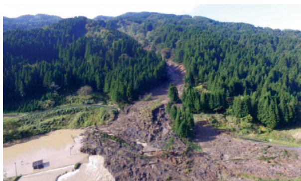
釜沢の被害状況 (新潟県糸魚川市)
