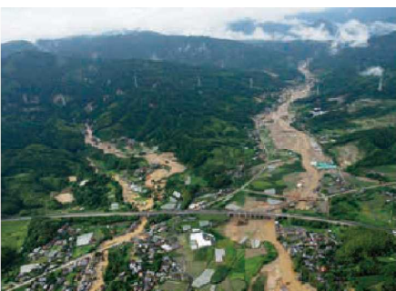
赤谷川・白木谷川下流の 土砂・流木流出状況
