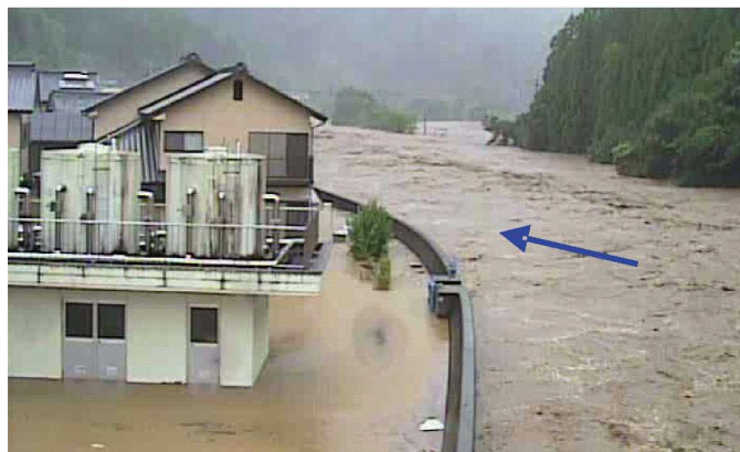
ばんじょう 番匠川左岸の浸水状況(大分県佐伯市)
