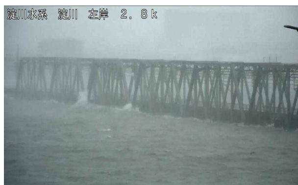
阪神電鉄なんば線淀川橋梁の状況 (大阪府大阪市福島区海老江)
