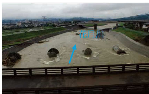
きゅうだい JR久大本線の鉄道橋の流出状況 (大分県日田市)
