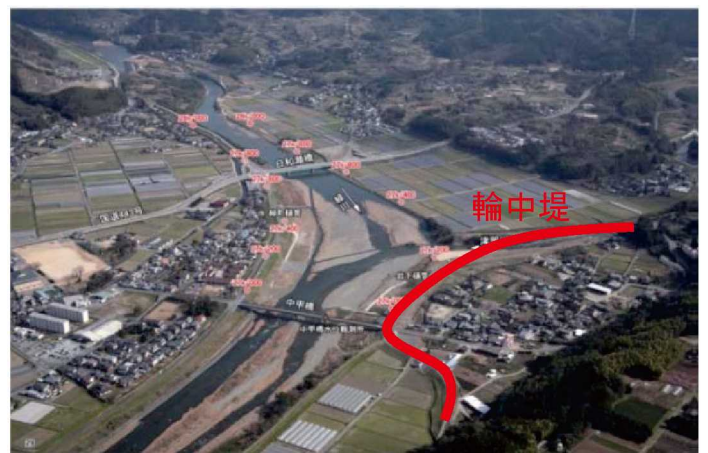
輪中堤の整備
