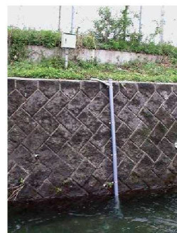
水位計の整備
