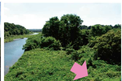
繁茂した樹木の伐採
