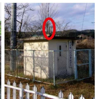
雨量計の整備
