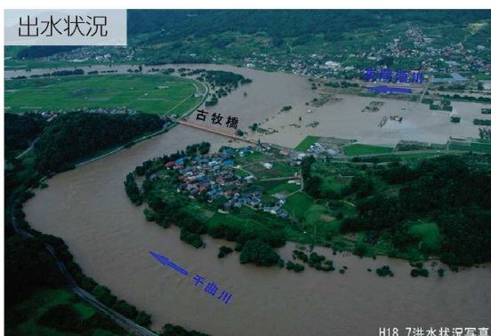
H18.7洪水状況写真
