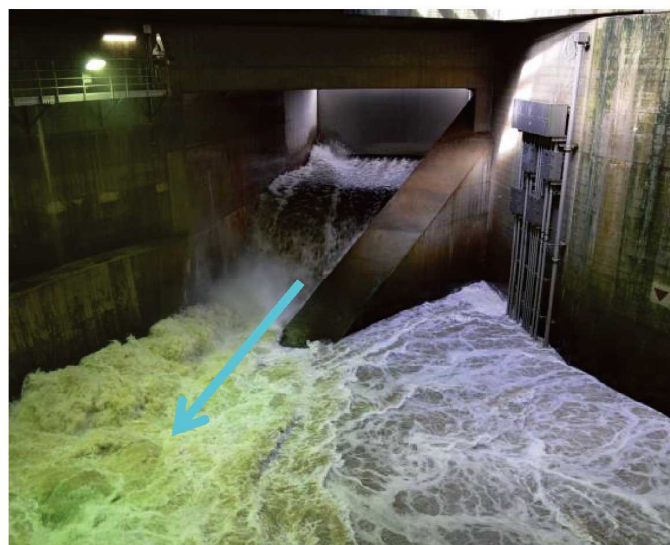
第3立坑（倉松川）の流入状況 (平成29年10月23日10:30撮影)
