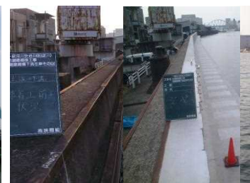
高潮堤防の耐震化（S52年～）
