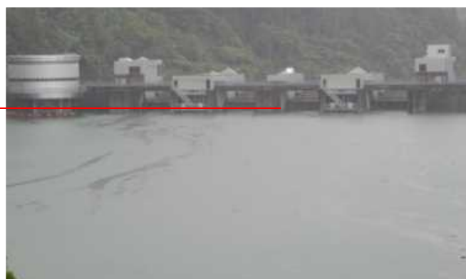
洪水時最高水位に近づく貯水状況 (7月6日10時頃)
