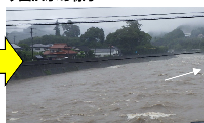
城井橋下流 (H30.7.6出水 16:00) (3時間後にピーク水位)
