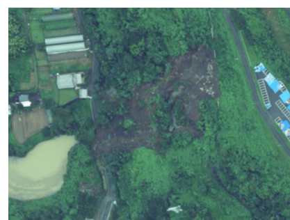
ボタ山わんぱく公園の法面崩壊 おおまち （佐賀県大町町）
