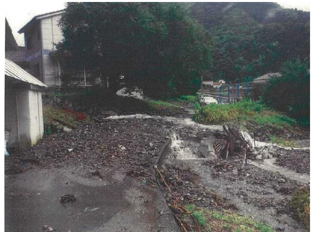
土石流による被害（広島県広島市）
