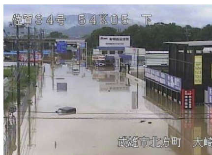
出水時の状況 国道34号（佐賀県武雄市） たけお
