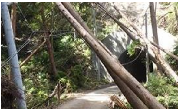
鴨川市 電柱・倒木倒壊の状況(鴨川市)
