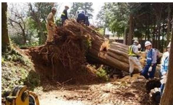
香取市 市道における倒木除去を実施（香取市）
