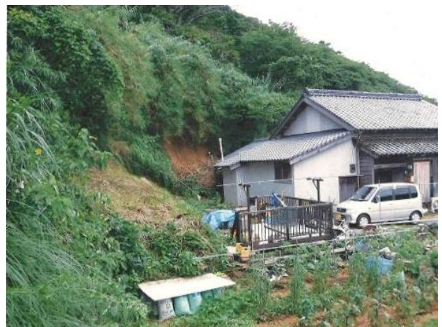
がけ崩れによる被害（長崎県五島市）
