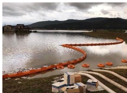
オイルフェンス設置状況 おおまち （佐賀県大町町）
