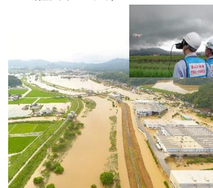
ドローン飛行部隊による現地調査 おおまち （佐賀県大町町）
