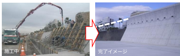
堤防のかさ上げ（千葉県浦安海岸）
