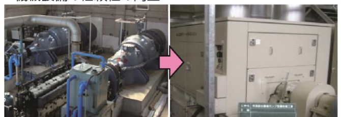
ポンプ設備の更新（水冷式から空冷式へ）
