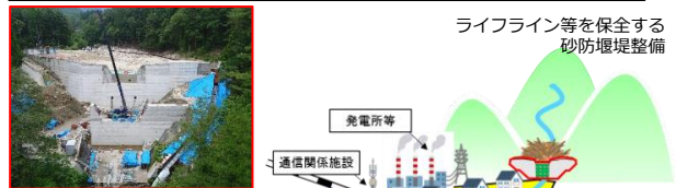
砂防堰堤の施工状況（長野県南木曾町）
