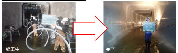
管更生による管きよの耐震対策（東京都）
