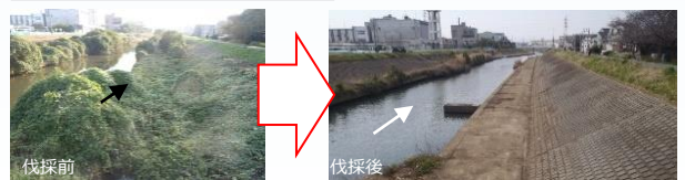
樹木伐採の事例（神奈川県鶴見川水系矢ふり）
