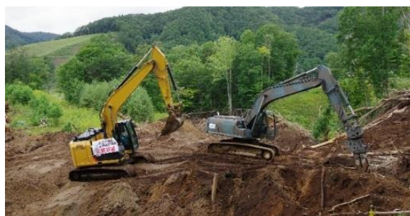
関係機関と連携した道路啓開 (北海道勇払郡厚真町)
