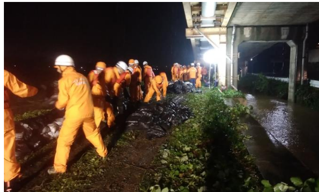
ひの 東京都日野市消防団 積み土のう工を実施 あさかわ (令和元年10月12日～13日:浅川右岸)
