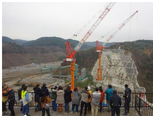
川上ダム建設現場の見学
