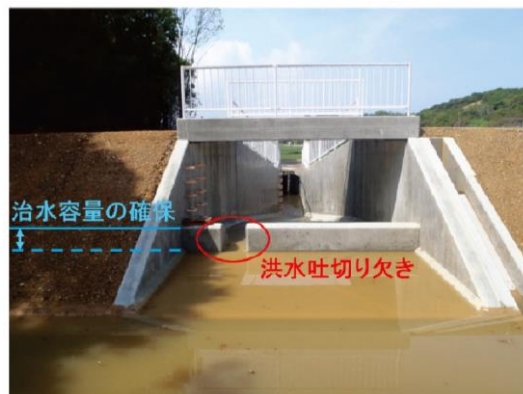
ため池の洪水吐に切り欠きの設置し、治水容量の確保を行った事例
