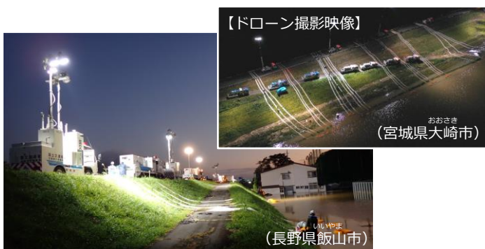
排水ポンプ車による24時間体制の緊急排水状況
