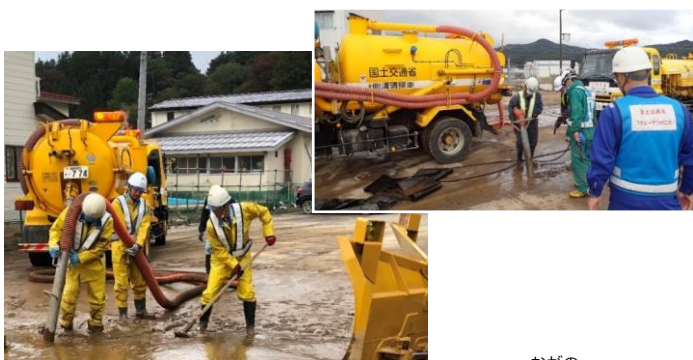
協力企業と一体となった堆積土砂の撤去（長野県長野市）
