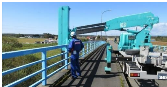
町道橋梁の緊急点検を実施 (北海道勇払郡厚真町)
