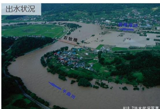
H18. 7洪水状況写真
