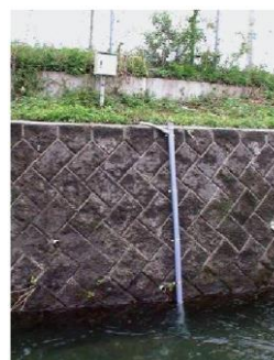
水位計の整備
