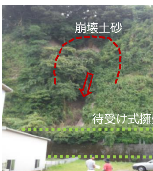
砂防関係施設が崩壊土砂を捕捉 かごしま さかのうえ (鹿児島市坂之上地区)
