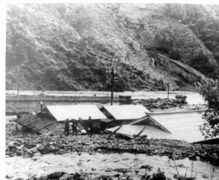
S36災 伊那市長谷の被災状況
