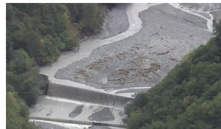
令和元年東日本台風 砂防堰堤が土砂・流木を捕捉 (小瀬戸第1砂防堰堤 (三峰川本川上流部))
