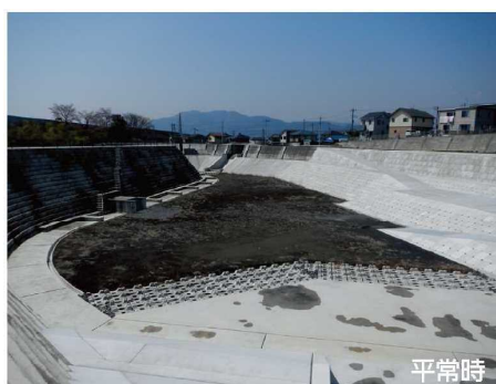
調整池整備 (静岡県)
