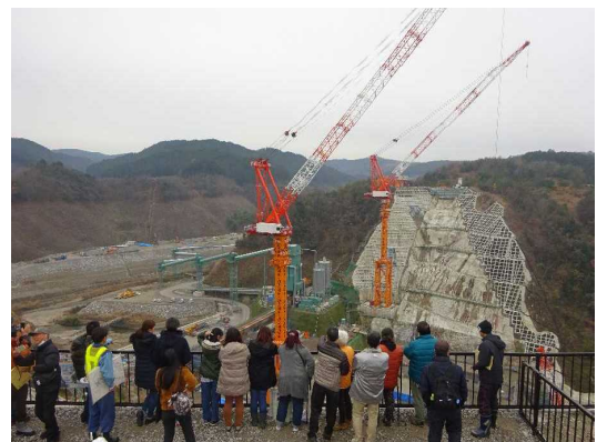
川上ダム建設現場の見学
