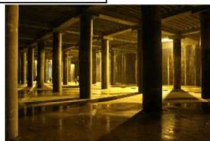
大規模地下貯留施設
