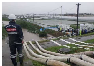
排水活動状況 くま (福岡県久留米市)
