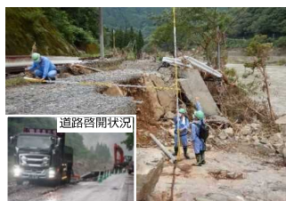
道路啓開状況 くま 国道219号 (熊本県球磨村)
