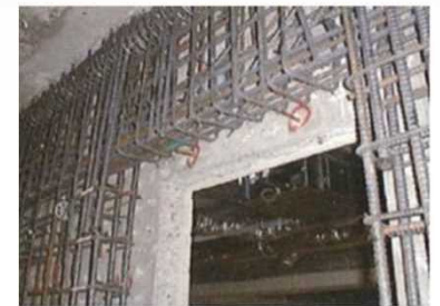
処理場の耐震化（躯体補強）
