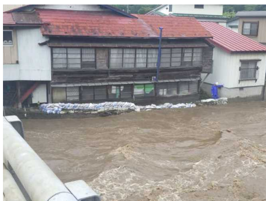
いちのへ 岩手県一戸町消防団 積土のう工を実施 まべち (令和2年7月12日～13日：馬淵川左岸)
