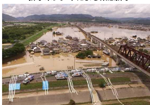
くらしき まび H30.7月豪雨（岡山県倉敷市真備町）
