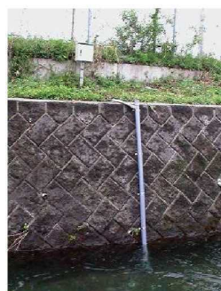
水位計の整備
