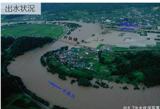
H18. 7洪水状況写真
