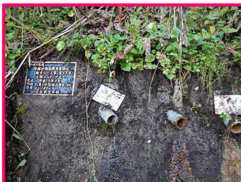
同地区内の既設横ボーリング工
