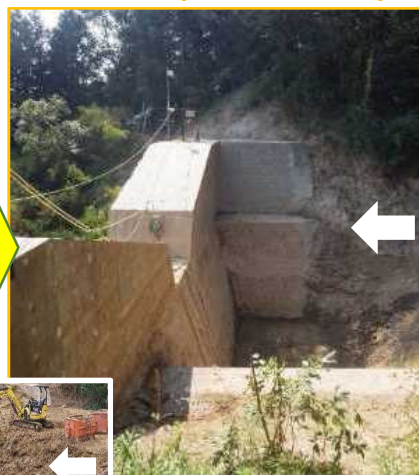
土砂撤去後(R2.8.20撮影)
