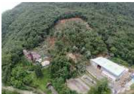
地すべりによる被害 ながの (長野県長野市)
