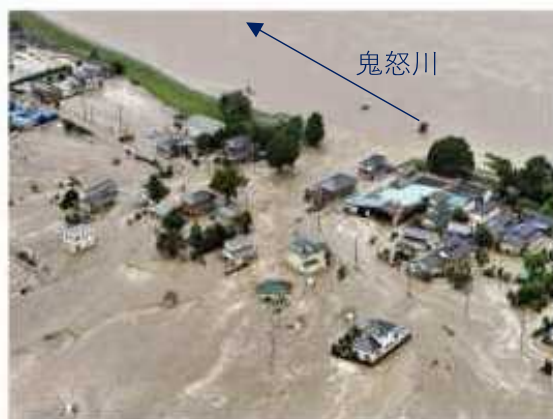
平成27年9月に発生した関東・東北豪雨における洪水の発生状況（鬼怒川）
