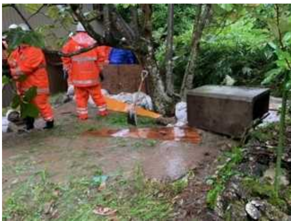
岐阜県下呂市消防団 積土のう工 （8月13～14日）飛騨川
