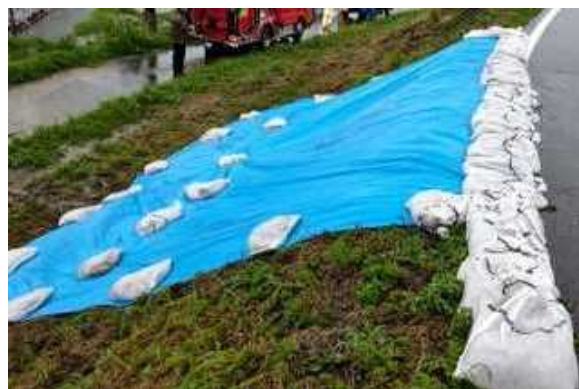
福岡県小郡市消防団 積土のう工＋シート張り工 （8月12～15日）宝満川
