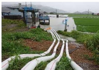
自治体の要請により排水活動 おおまち （佐賀県大町町）
