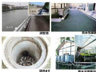
雨水貯留浸透施設の例
