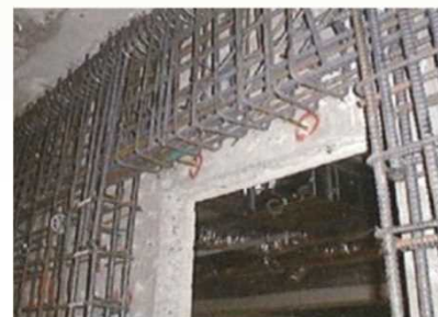
処理場の耐震化（躯体補強）
