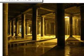
大規模地下貯留施設
