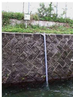
水位計の整備
