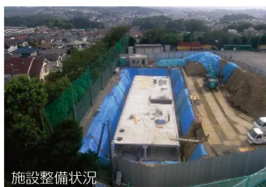
施設整備状況
