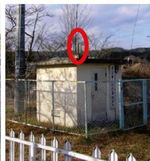
雨量計の整備
