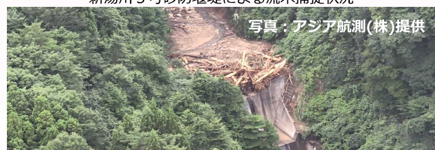
新湯川4号砂防堰堤による流木捕捉状況
