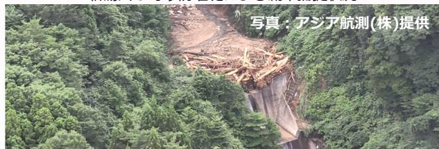
新湯川4号砂防堰堤による流木捕捉状況
