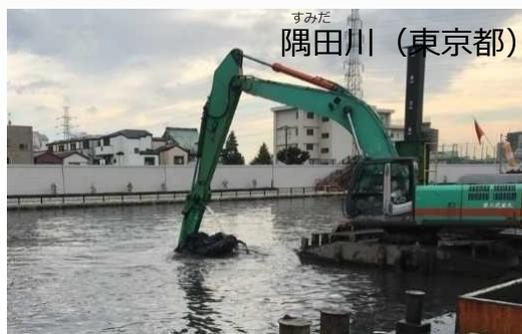
水質汚濁対策として底泥の浚渫を行い、水質の改善を図ります
