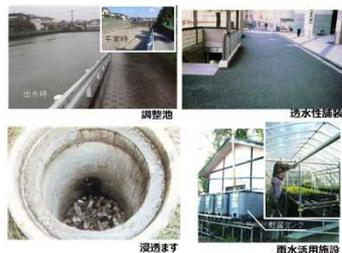
雨水貯留浸透施設の例
