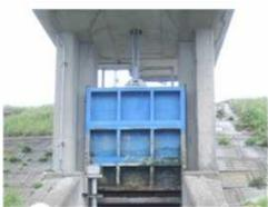
老朽化により機能低下した樋門ゲートの更新と合わせ、ゲート材質や開閉機構を変更
