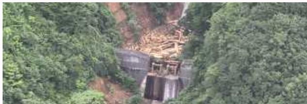
新湯川3号砂防堰堤による流木捕捉状況
