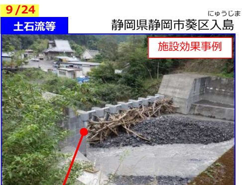
砂防堰堤が土石流を捕捉
