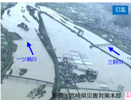
ひとつせ 一ツ瀬川水系一ツ瀬川、三財川の 内水氾濫による浸水状況 (宮崎県西都市・新富町)
