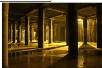
大規模地下貯留施設
