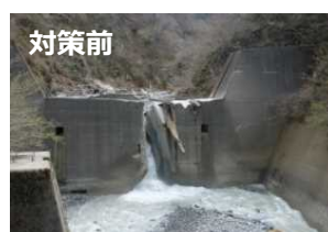
常時流水の影響による摩耗の進行
