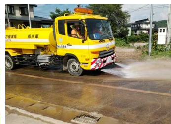
道路上の泥土を清掃 (山形県飯豊町)
