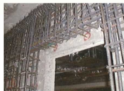
処理場の耐震化（躯体補強）
