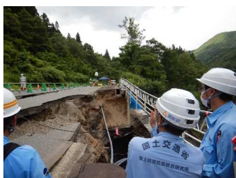
県管理道路の高度技術指導 (山形県米沢市)
