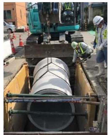
枝線(増径)施工状況
