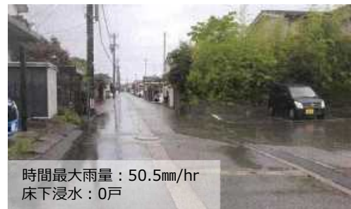
浸水状況(令和4年8月20日)
