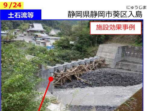
砂防堰堤が土石流を捕捉
