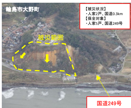
国道249号を寸断した地すべり災害
