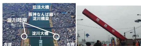
例：淀川水系淀川 淀川陸閘整備事例
