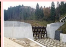
砂防関係施設整備
