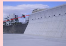
海岸保全施設整備
