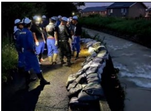
しまだし 静岡県島田市消防団 積み土のう工 （令和6年8月31日～9月1日） とうこうじやがわ きしちょう 東光寺谷川（岸町地先）
