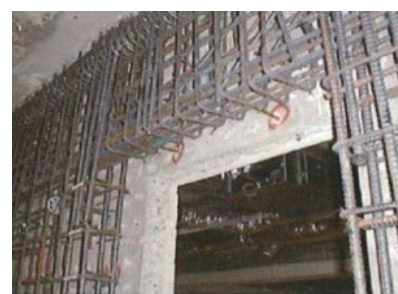
処理場の耐震化（躯体補強）
