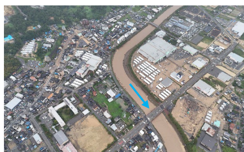
かわらたかわ 河原田川(石川県輪島市)
