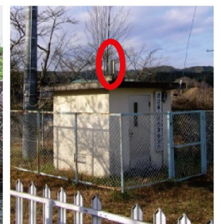
雨量計の整備
