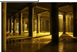
大規模地下貯留施設
