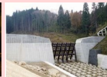
砂防関係施設整備
