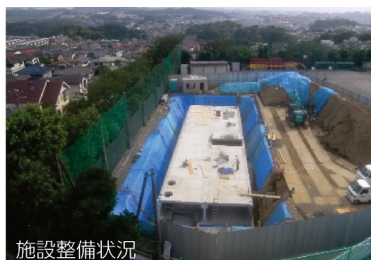
施設整備状況
