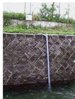
水位計の整備
