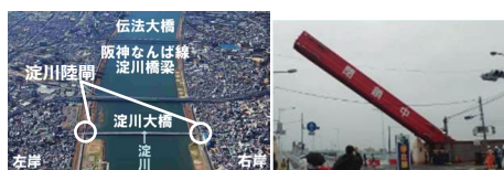
例：淀川水系淀川 淀川陸閘整備事例
