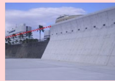
海岸保全施設整備
