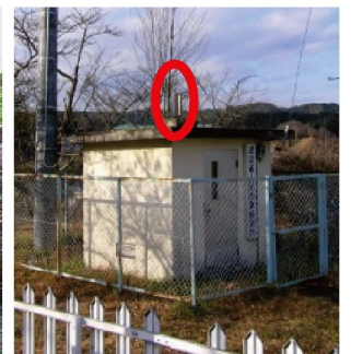
雨量計の整備
