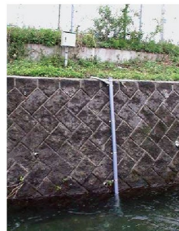
水位計の整備
