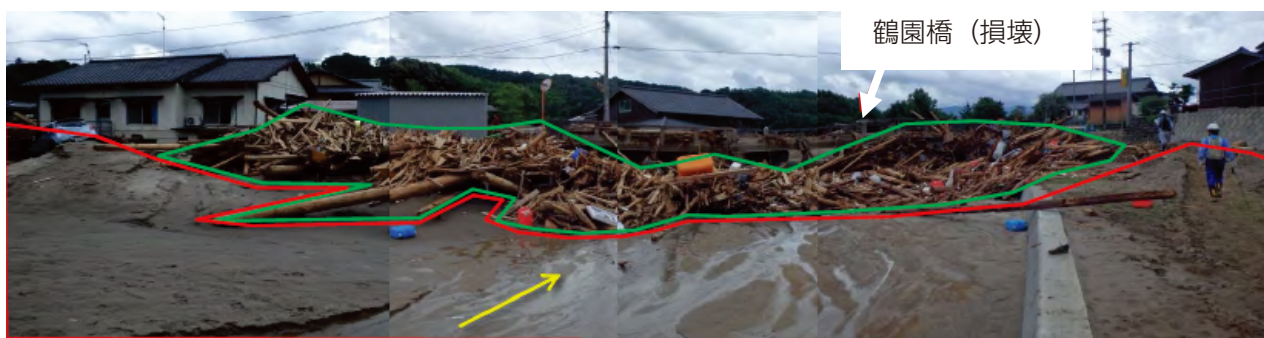
つるくにばし 赤谷川の鶴園橋付近の流木被害状況
