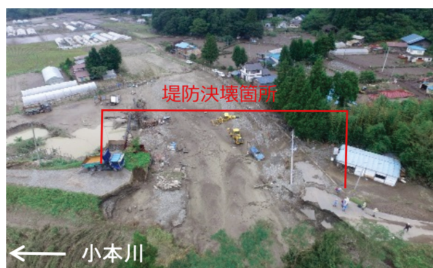
堤防決壊状況
