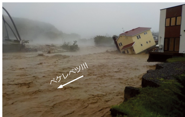
台風第10号の影響に伴う河岸洗掘状況 提供：北海道 十勝川水系ペケレベツ川（上川郡清水町字清水地先）
