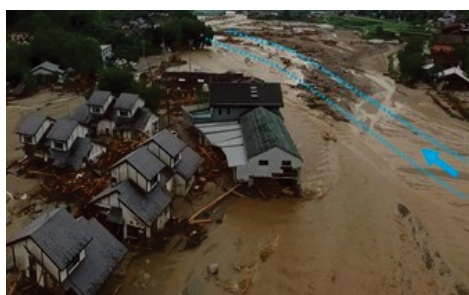
赤谷川中流付近のはん濫状況
