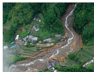
ほうじゅ 宝珠山川の崩壊状況
