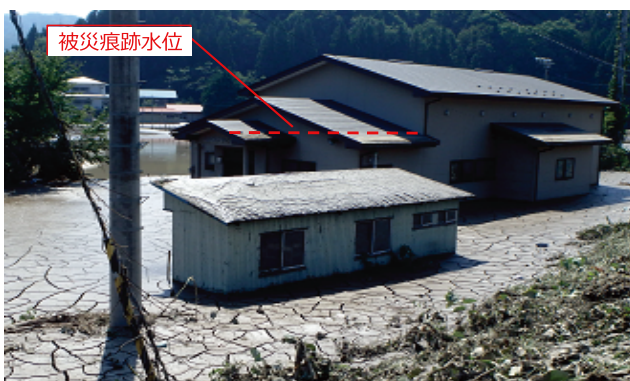
浸水解消後の流入土砂堆積状況
