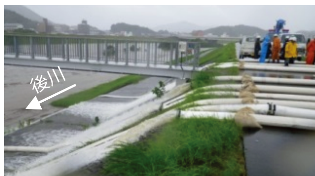
渡川水系後川排水ポンプ車排水状況（高知県四万十市古津賀）
