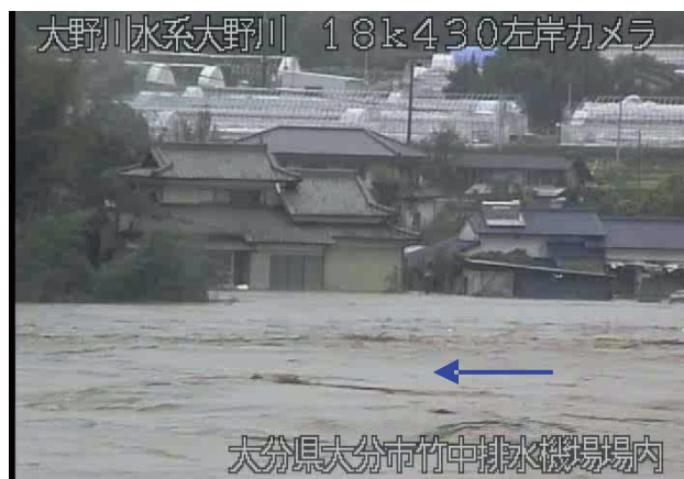
大野川水系大野川 18k430左岸カメラ 大分県大分市竹中排水機場内 大野川右岸付近の浸水状況 (大分県大分市)
