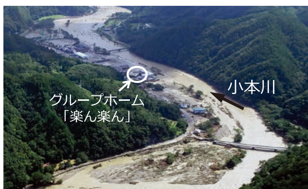
小本川周辺の浸水状況
