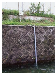
水位計の整備
