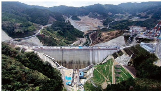
五ヶ山ダム（福岡県）
