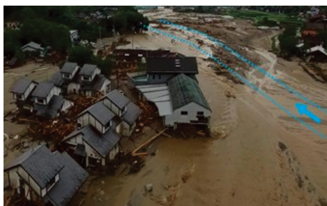
赤谷川中流付近のはん濫状況
