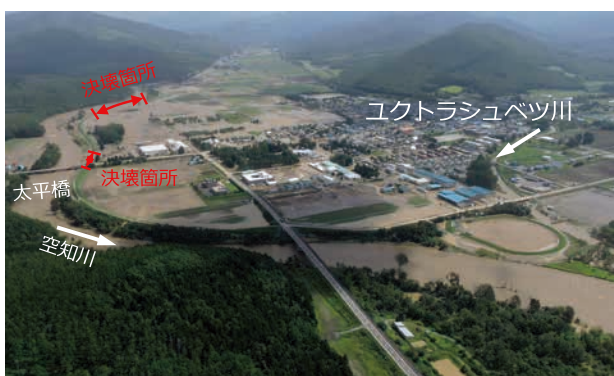
台風第10号の影響等による決壊状況 石狩川水系空知川（空知郡南富良野町幾寅地先）
