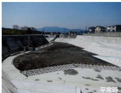
調整池整備 (静岡県)
