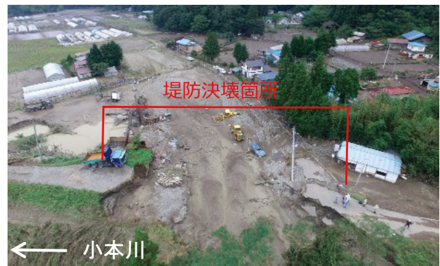
堤防決壊状況
