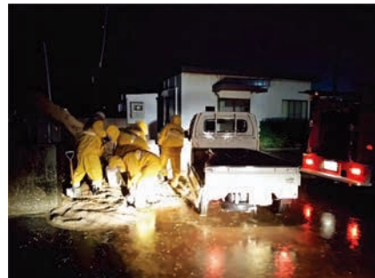
愛媛県伊予市消防団土のう作成の様子 (9月17日台風第18号:重信川左岸)
