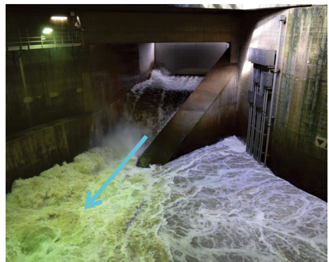
第3立坑（倉松川）の流入状況 （平成29年10月23日10:30撮影）
