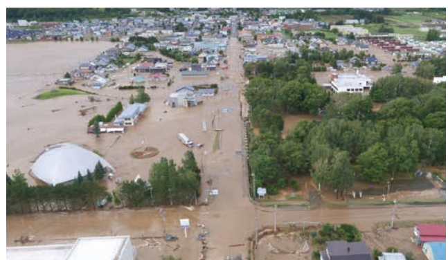
台風第10号の影響に伴う浸水状況 石狩川水系空知川（空知郡南富良野町幾寅地先）
