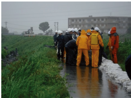
石川県小松市消防団積み土のう工を実施 (8月8日台風第5号:梯川右岸)
