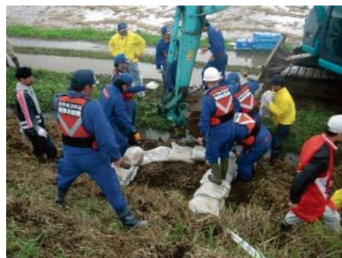
福島県矢吹町消防団月の輪工を実施 (10月23日台風第21号:阿武隈川左岸)
