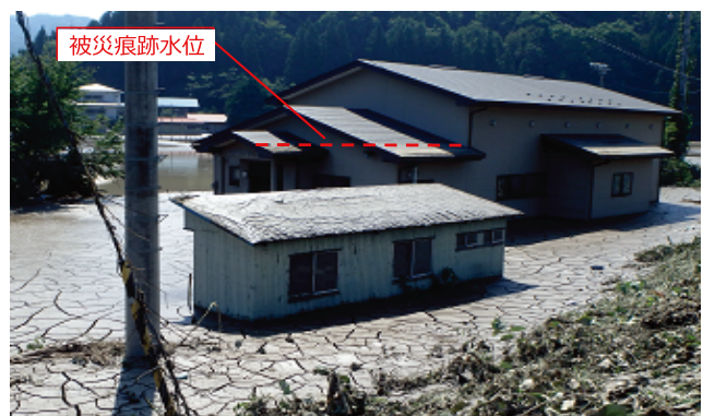
浸水解消後の流入土砂堆積状況
