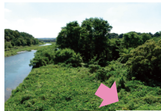
繁茂した樹木の伐採
