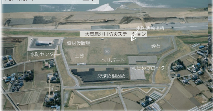
大高島河川防災ステーション (群馬県：利根川)
