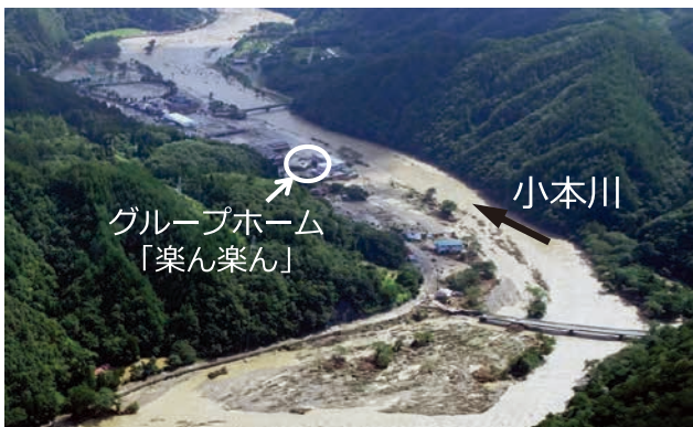
小本川周辺の浸水状況
