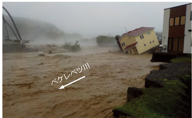
台風第10号の影響に伴う河岸洗掘状況 提供：北海道 十勝川水系ペケレベツ川（上川郡清水町字清水地先）
