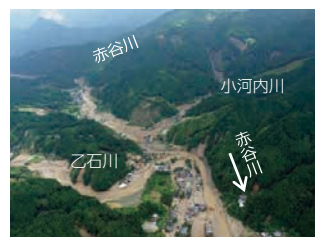
赤谷川における土砂・流木による埋塞状況
