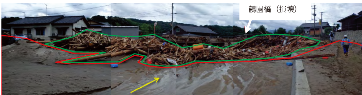
つるくにばし 赤谷川の鶴国橋付近の流木被害状況
