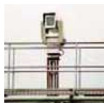
CCTVカメラの整備
