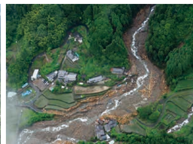
ほうじゅ 宝珠山川の崩壊状況
