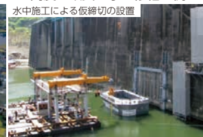
鶴田ダムの再開発事業（鹿児島県薩摩郡さつま町）
