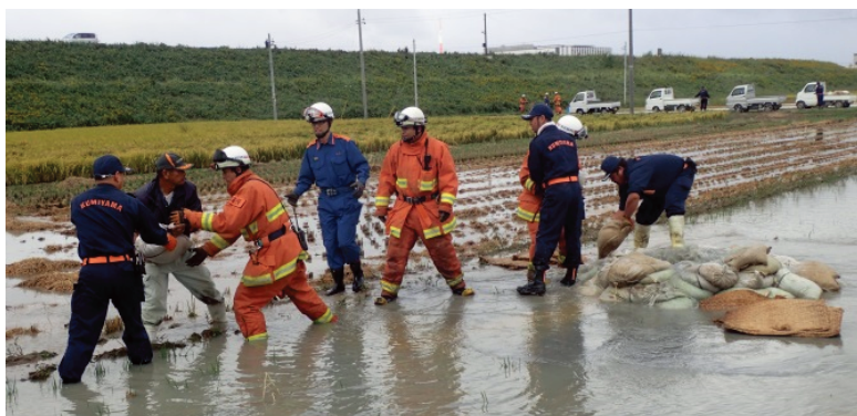
京都府久御山町消防団釜段工を実施 (10月23日台風第21号:木津川右岸)
