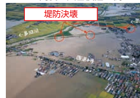
平成27年9月関東・東北豪雨における災害復旧工事（宮城県大崎市）
