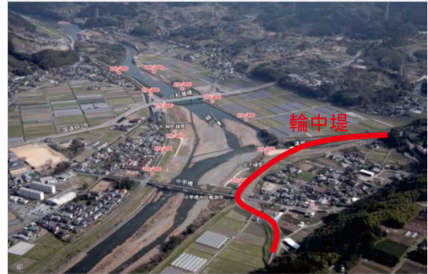
輪中堤の整備
