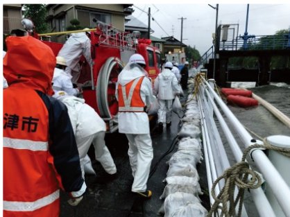
静岡県焼津市消防団積み土のう工を実施 (6月21日梅雨前線豪雨:小石川左岸)
