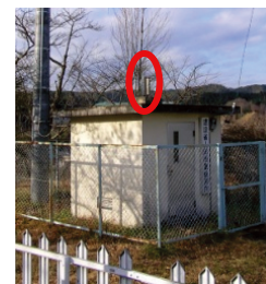
雨量計の整備
