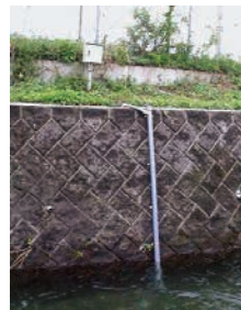
水位計の整備
