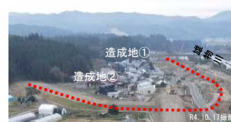
移転家屋の建設が進む状況
