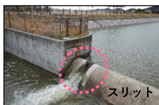
▲スリットの設置状況
