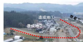
移転家屋の建設が進む状況
