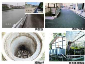
雨水貯留浸透施設の例
