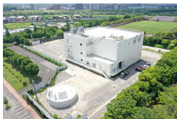
雨水ポンプ場
