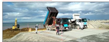
養浜材の荷下・投入状況 (R4.8.18 撮影)
