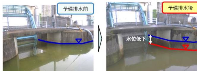
予備排水による貯水容量の確保状況
