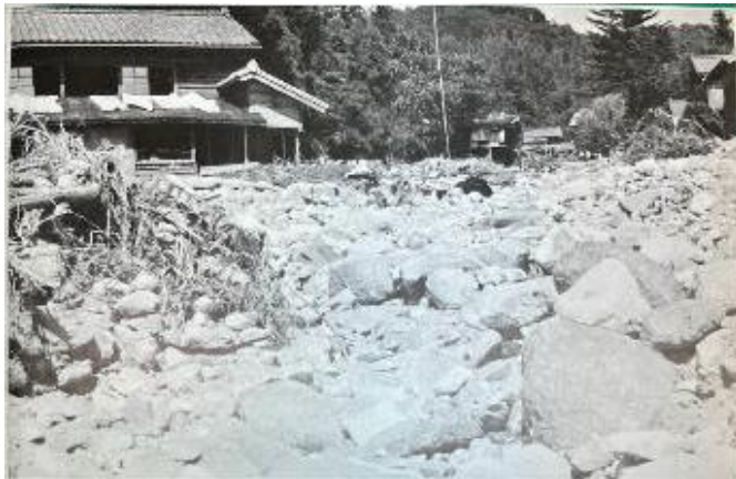
「羽越水害」の被害写真
