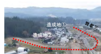
移転家屋の建設が進む状況
