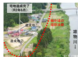
移転先宅地造成完了状況
