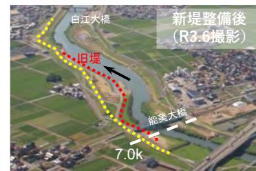
引堤(石川県梯川水系梯川)
