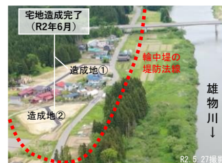
移転先宅地完成完了状況
