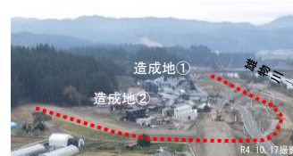
移転家屋の建設が進む状況
