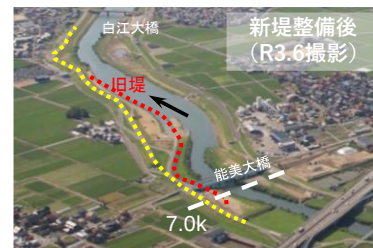
引堤(石川県梯川水系梯川)
