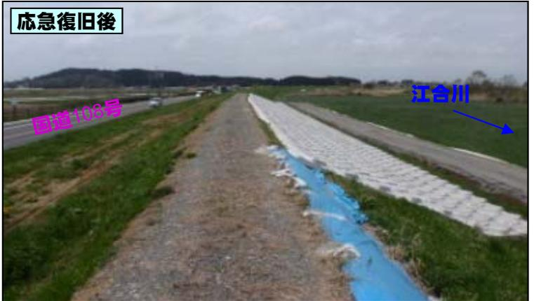
盛土に加え、遮水シート、大型連結ブロック張り等により応急復旧を実施
