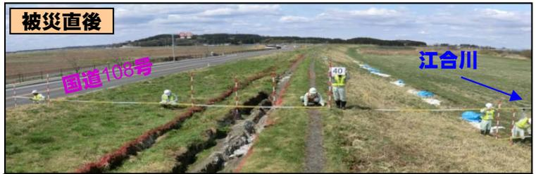
東北地方太平洋沖地震により、堤防上端の亀裂、堤防斜面の崩れ等の被害が発生
