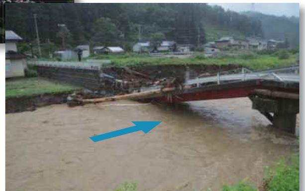
最上川水系吉野川での橋梁の落橋
