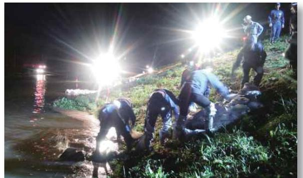
まち側の堤防法尻から漏水した箇所
