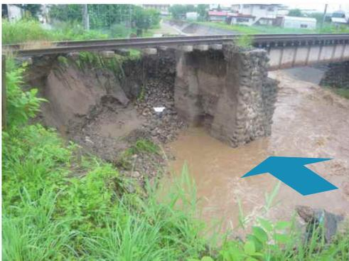
最上川水系織機川(鉄道橋の宙吊り状況)
