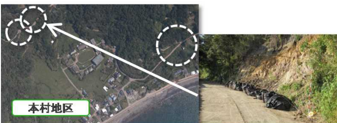
本村地区における土砂災害被害状況(人家に被害なし)
