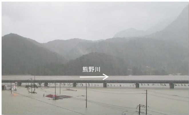
新宮川水系熊野川の出水状況(和歌山県新宮市熊野川町日足)
