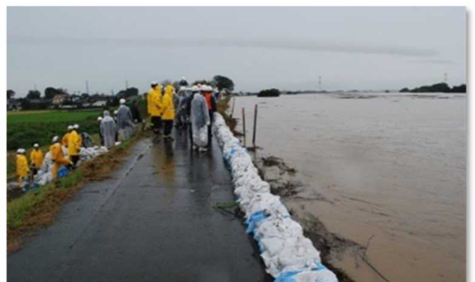
越水対策として「積み土のう工」を実施 (9月11日／宮城県大崎市)
