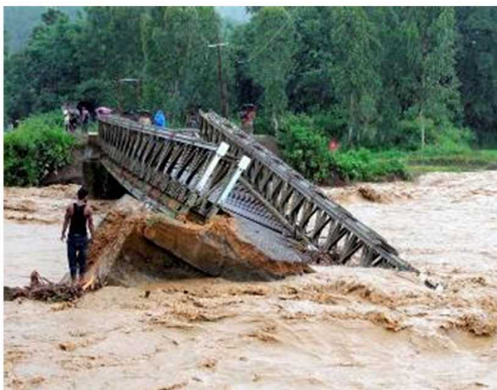
洪水による橋梁決壊の状況(インド)
