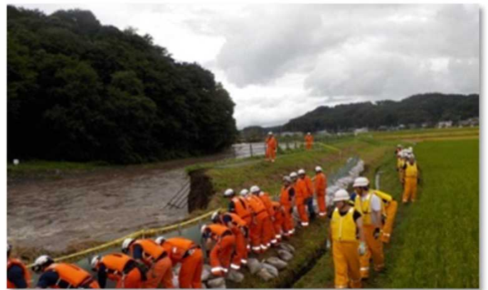
土留鋼板を使用した「改良積み土のう工」の実施 (9月10日／栃木県宇都宮市)
