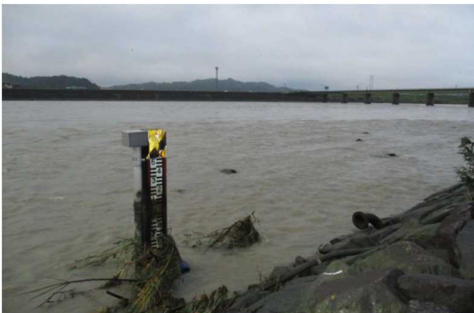
櫛田川左岸10.5km付近可動堰上流JR橋
