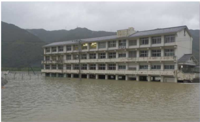
那賀川水系那賀川の浸水状況(徳島県阿南市加茂町南不け)
