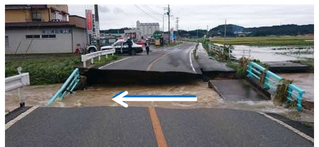
北上川水系迫川(主)栗駒岩出山線 熊川橋の落橋(宮城県栗原市栗駒)
