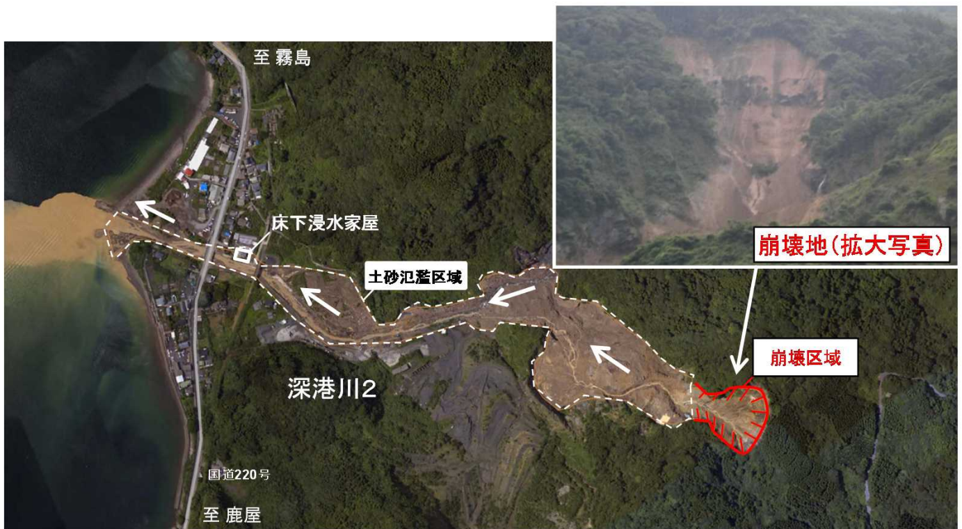
土石流災害の状況（航空写真）
