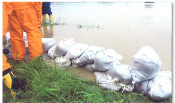
越水対策として「積み土のう工」を実施 (9月10日／茨城県常総市)
