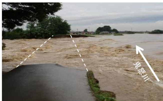
決壊箇所の状況(9月10日)
