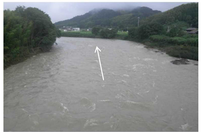
櫛田川松阪多気橋付近の出水状況
