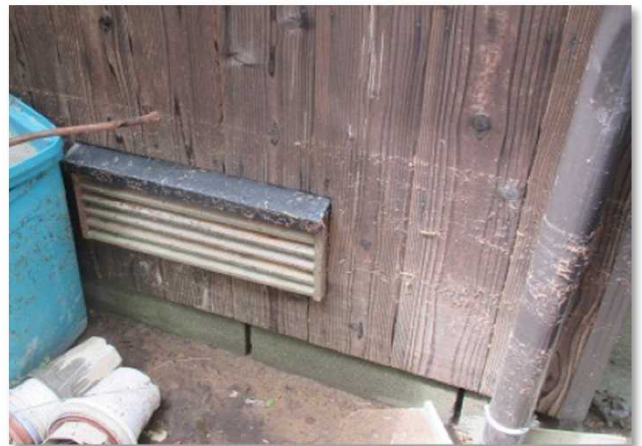
深川川水系深川川の内水被害痕跡(長門市深川湯本地先)
