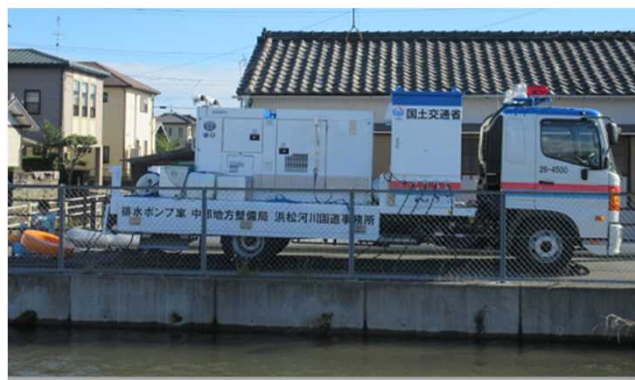
国土交通省による作業状況(浜松市南区新橋町地内)
