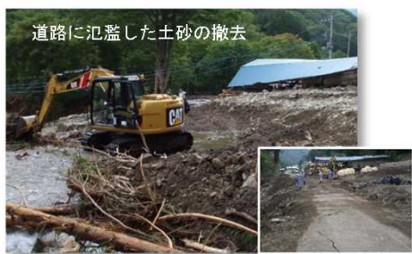
寸断された道路の応急復旧
