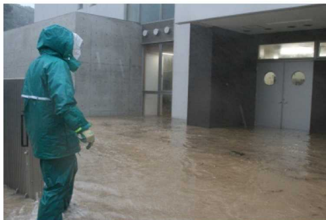
深川川水系深川川 内水被害状況(長門市東深川 深川小学校)
