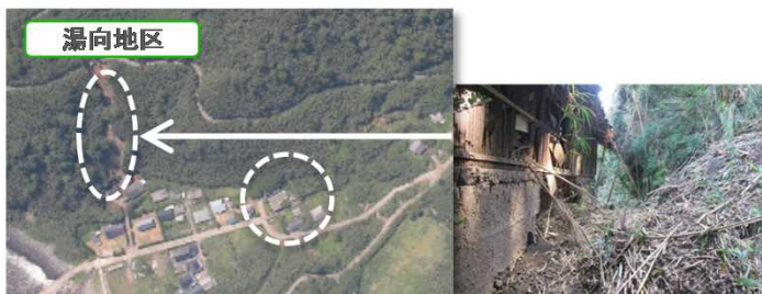
湯向地区における土砂災害被害状況(倉庫へ土砂が流入)
