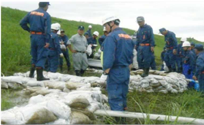
漏水箇所への「月の輪工」の実施 (9月11日／宮城県大崎市)
