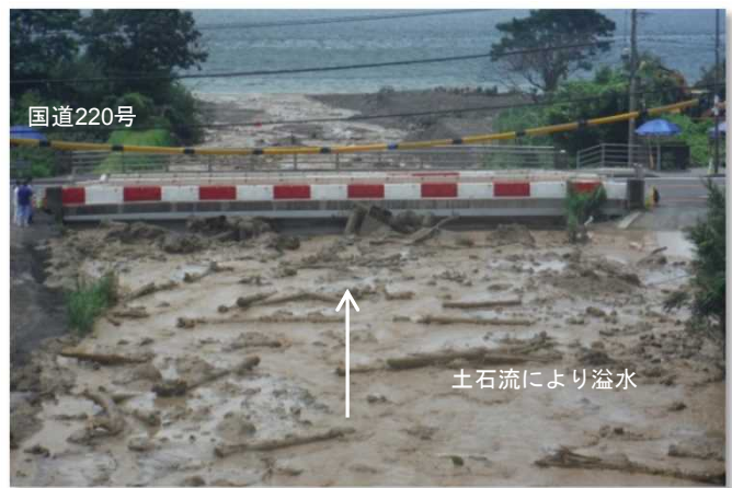
7月28日土石流発生状況②(九州地方整備局撮影)
