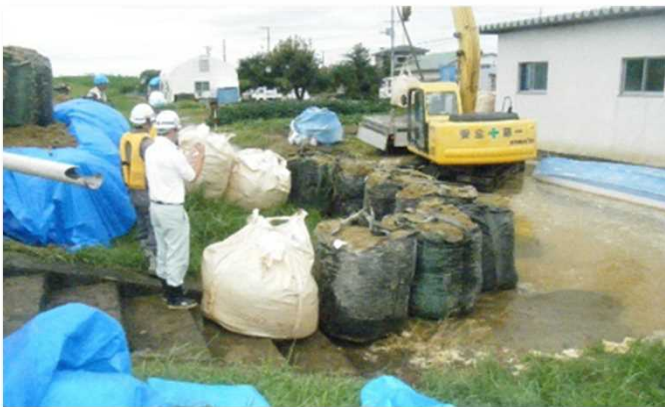
大型土のうを使用した「月の輪工」の実施 (9月11日／宮城県大崎市)
