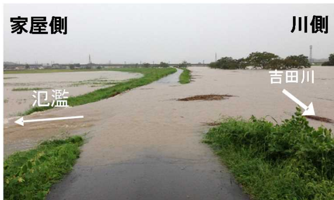
鳴瀬川水系吉田川の越水状況(宮城県大和町桜和田)
