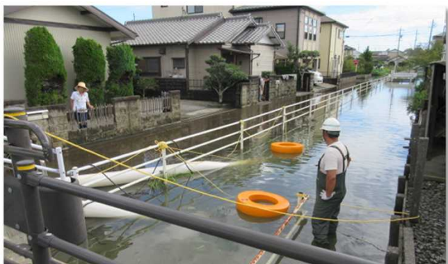
国土交通省による作業状況(浜松市南区新橋町地内)
