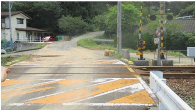
深川川水系深川川の内水被害痕跡(長門市深川湯本地先)
