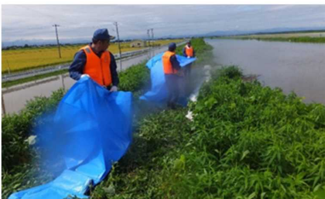
漏水防止対策として「シート張り工」を実施 (9月11日／宮城県大崎市)
