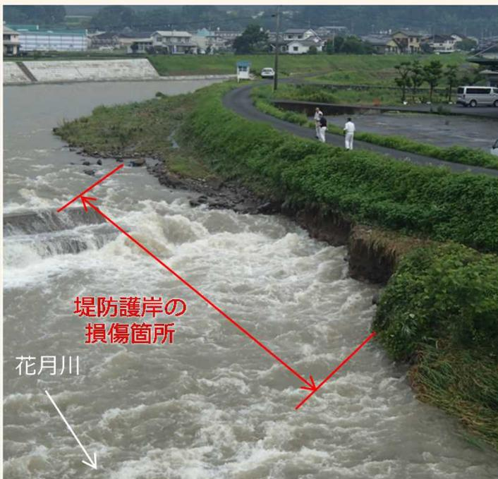
筑後川水系花月川における堤防護岸の損傷状況（大分県日田市西有田地先）
