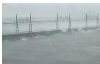
台風第21号 （大阪府大阪市西淀川区）
