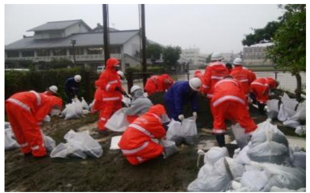
愛媛県内子町消防団 土のう作りを実施 (平成30年7月6日:小田川右岸)
