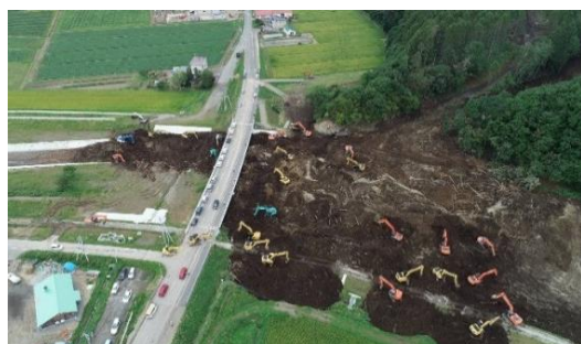
24時間体制で河道閉塞箇所における土砂撤去作業 ゆうふつ あつま あづまがわほろないばし (北海道勇払郡厚真町・厚真川幌内橋付近)
