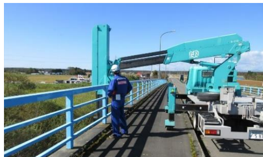
町道橋梁の緊急点検を実施 ゆうふつ あつま (北海道勇払郡厚真町)
