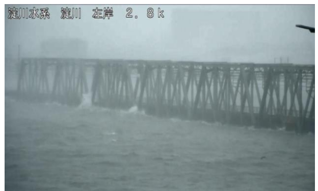
淀川水系 淀川 左岸 2.8k 阪神電鉄なんば線淀川橋梁の状況 えびえ （大阪府大阪市福島区海老江）
