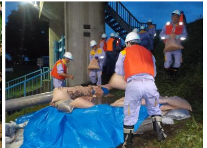
岐阜県岐阜市日置江水防団 月の輪工を実施 (平成30年7月8日:長良川左岸)
