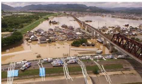
排水ポンプ車23台を集結し24時間体制で排水 （岡山県倉敷市真備町）
