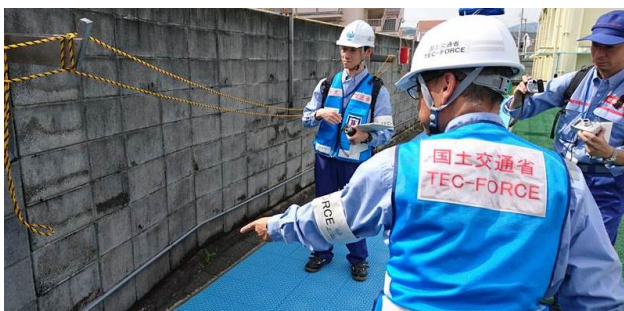
ブロック塀の亀裂等確認 (大阪府高槻市) たかつき
