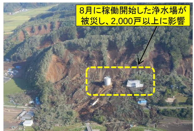
あつま とみさと 土砂崩壊の状況（北海道厚真町富里地区）
