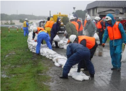
兵庫県小野市消防団 積み土のう工を実施 (平成30年7月7日:加古川右岸)
