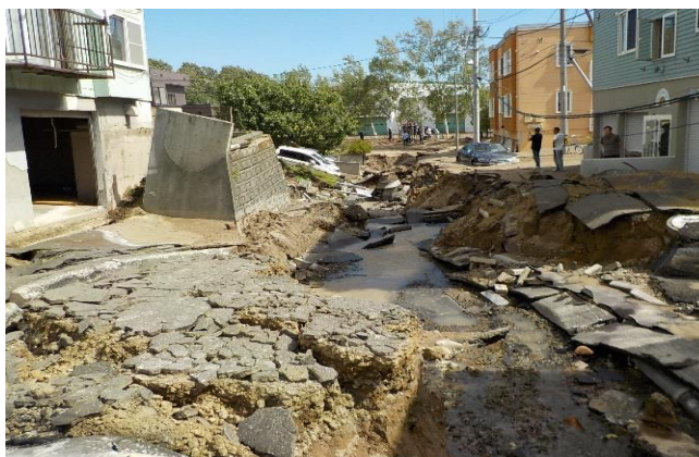
札幌市の液状化による被害（北海道札幌市）
