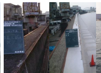
高潮堤防の耐震化（S52年～）
