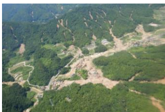
平成30年7月豪雨 くれ やすうら （広島県呉市安浦町）
