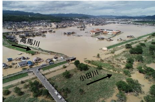
たかはし まび 高梁川水系小田川の堤防決壊状況（岡山県倉敷市真備町）
