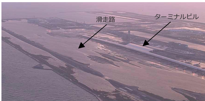
せんしゅう 関西国際空港の浸水状況（大阪府泉佐野市泉州空港）
