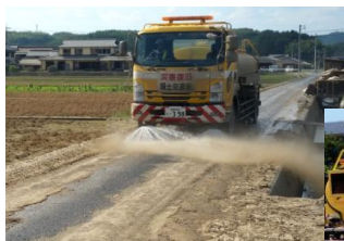
散水車による防塵対策 （岡山県倉敷市真備町）
