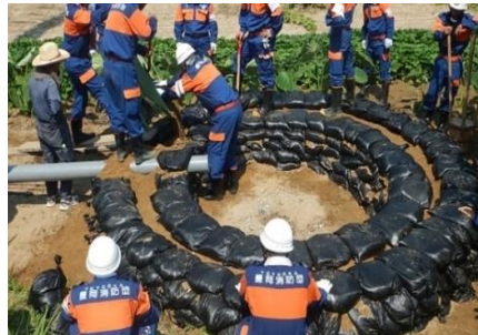
兵庫県豊岡市消防団 釜段工を実施 (平成30年7月15日:円山川左岸)
