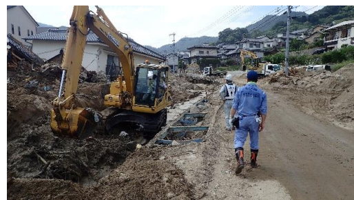
市街地の土砂等の撤去作業 （広島県安芸郡坂町）
