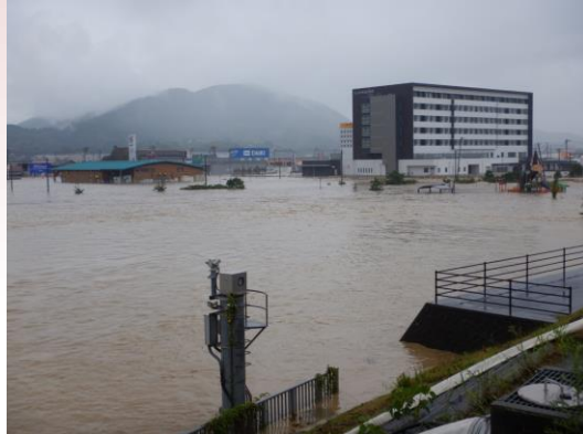
おおず 平成30年7月豪雨（愛媛県大洲市）
