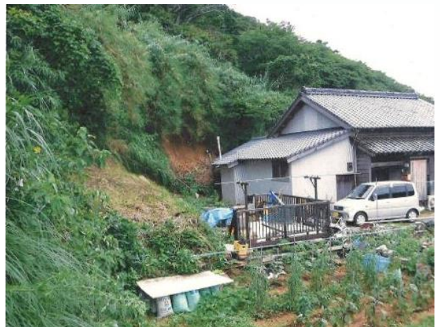
がけ崩れによる被害（長崎県五島市）
