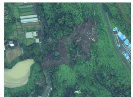
ポタ山わんぱく公園の法面崩壊 （佐賀県大町町）
