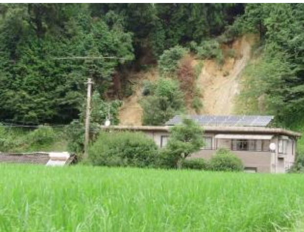
がけ崩れによる被害（福岡県飯塚市）
