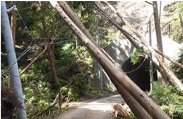
電柱・倒木倒壊の状況(鴨川市) かもがわ
