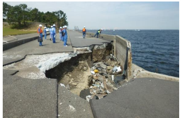
港におけるパラペット倒壊の状況(横浜市) よこはま
