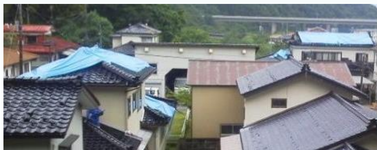
屋根瓦落下等（ブルーシートで養生） つるおか（鶴岡市）
