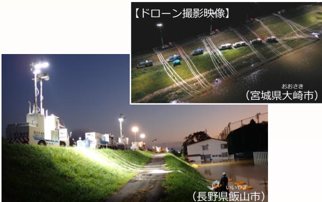
排水ポンプ車による24時間体制の緊急排水状況（長野県飯山市）
