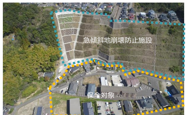
傾斜地崩壊防止施設 かごしま たがみ 傾斜地崩壊防止施設（鹿児島市田上）
