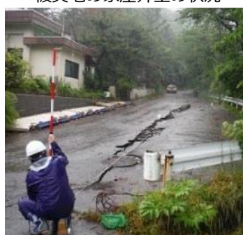
つるおか 道路の被災状況調査（鶴岡市）
