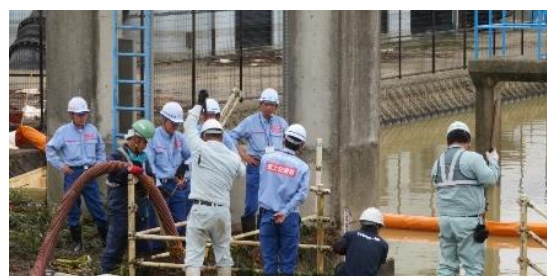
協力企業と連携した流出油の除去作業 （佐賀県大町町）
