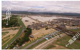
おだ 小田川の浸水状況 （岡山県倉敷市真備町）
