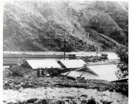
S36災 伊那市長谷の被災状況
