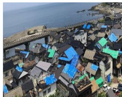
被災地の屋根瓦の状況
