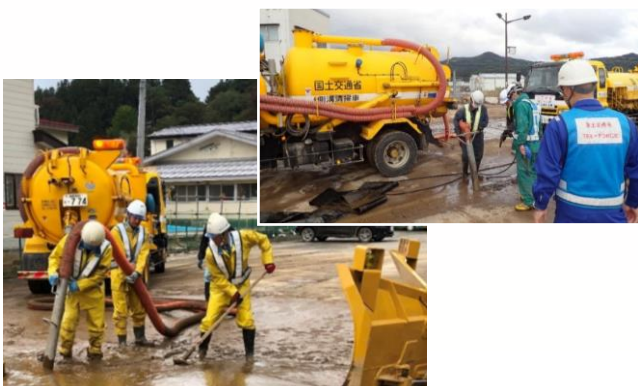
協力企業と一体となった堆積土砂の撤去（長野県長野市）
