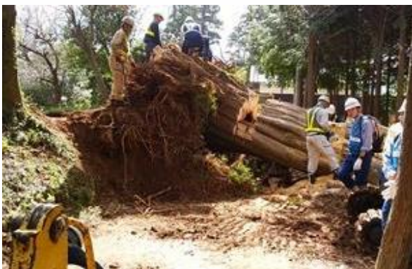
市道における倒木除去を実施(香取市) かとり
