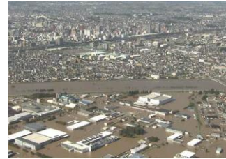
あぶくま 阿武隈川の氾濫状況 （福島県郡山市）
