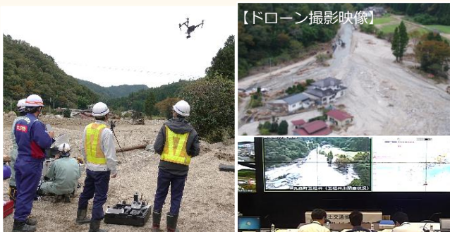
ドローンを活用した被災状況調査と衛星回線を用いたリアルタイム映像配信（宮城県丸森町）
