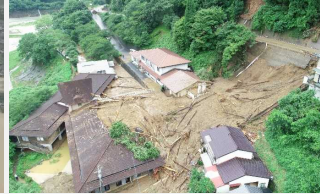
土砂災害の状況 ひた (大分県日田市)
