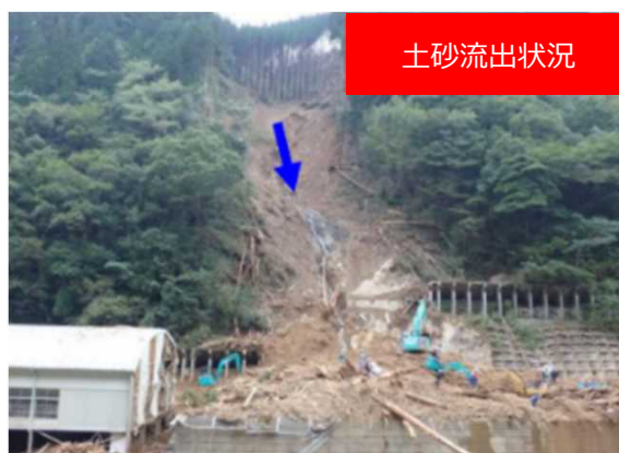
宮崎県椎葉村で土砂災害が発生
