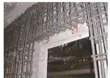
処理場の耐震化（躯体補強）
