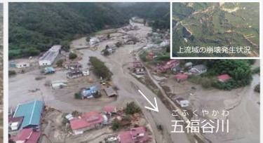
土砂災害の状況 まるもり (宮城県丸森町)
