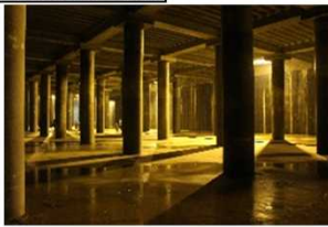
大規模地下貯留施設
