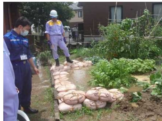
ほんじょう かまだん 岐阜県岐阜市本荘水防団 釜段工を実施 ながら (令和2年7月8日：長良川左岸)
