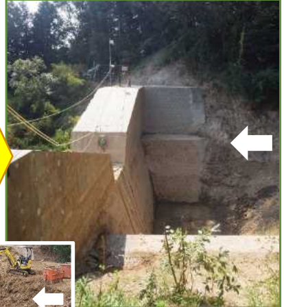
土砂撤去後(R2.8.20撮影)
