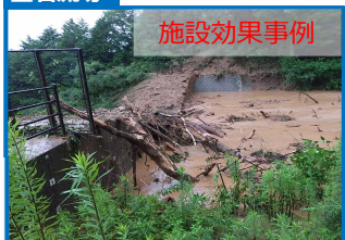
砂防えん堤が土石流を捕捉
