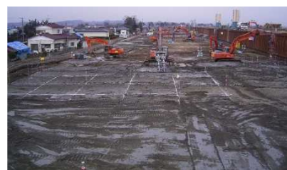
復旧時における基礎地盤改良
