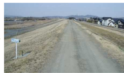
H23.3地震後の状況（被災なし）
