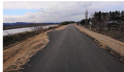
R3.2地震後の状況（被災なし）
