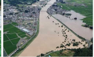
もがみ 最上川の氾濫状況 おおいしだ (山形県大石田町)
