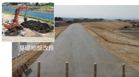
復旧完了後（H25.3）
