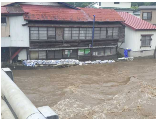
いちのへ 岩手県一戸町消防団 積土のう工を実施 まべち (令和2年7月12日～13日：馬淵川左岸)
