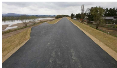
復旧完了後（H24.4）
