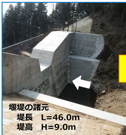
土石流発生前 (H29.3撮影)
