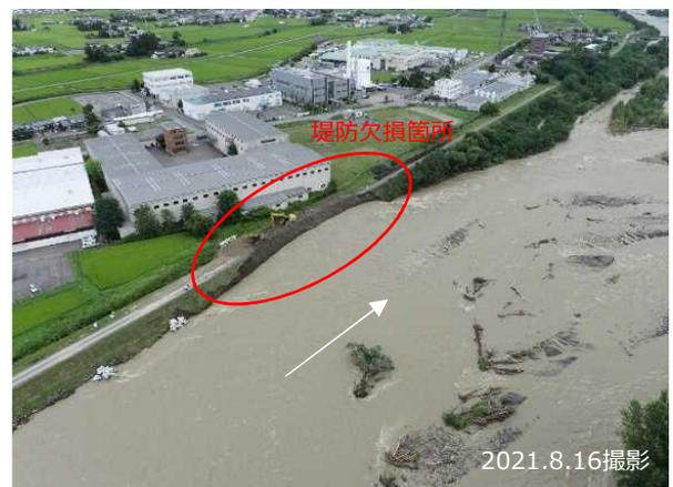
ダム直下の犀川急流部で発生した堤防欠損被害の侵食抑制や迅速な緊急復旧工事の対応に寄与
