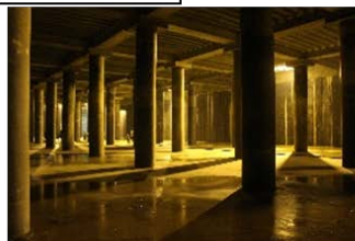
大規模地下貯留施設
