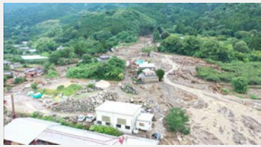
土砂災害の状況 くるめし たぬし まるまち たけの (福岡県久留米市田主丸町竹野)
