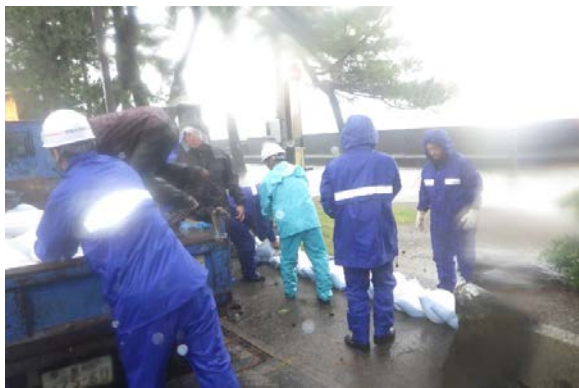
いせ 三重県伊勢市消防団 積み土のう工 （令和5年6月2～3日） ふたみ 二見地区海岸
