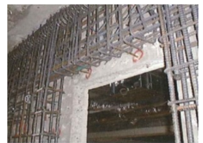
処理場の耐震化（躯体補強）
