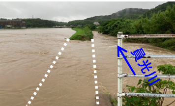
神田川水系具光川堤防決壊状況 (山口県下関市)
