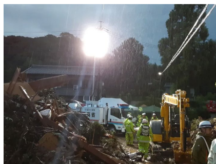
土砂災害現場での照明支援 (愛知県蒲郡市)
