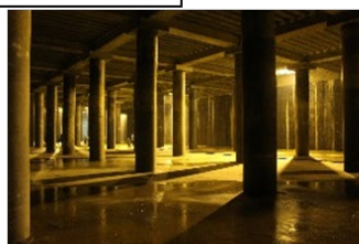
大規模地下貯留施設
