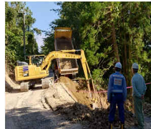
道路啓開作業 (石川県珠洲市)
