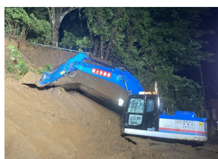
遠隔操縦式バックホウによる道路啓開 (神奈川県伊勢原市)
