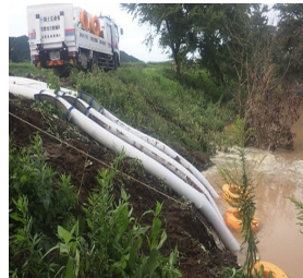
排水作業(町野川) (石川県輪島市)
