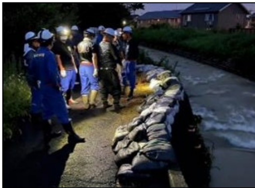
しまだし 静岡県島田市消防団 積み土のう工 とうこうじやがわ きしちょう (令和6年8月31日～9月1日) 東光寺谷川（岸町地先）
