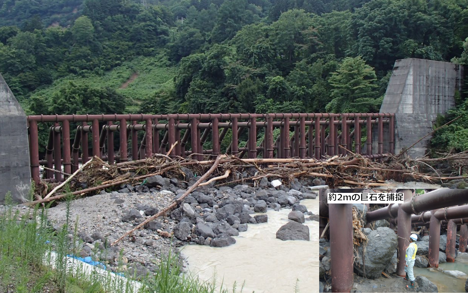
【出水後】令和6年7月29日撮影 もがみがわ どうざんがわ おおくらむらみなみやま 最上川水系銅山川（山形県大蔵村南山）
