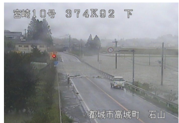
大淀川沿川の内水による浸水状況 (宮崎県都城市)
