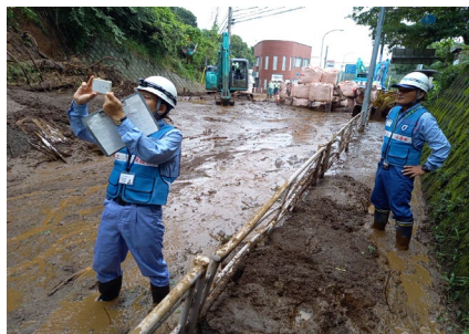
道路啓開作業 (神奈川県伊勢原市)
