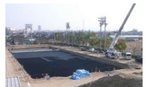
グラウンドの雨水貯留施設（工事状況）【愛知県岡崎市】
