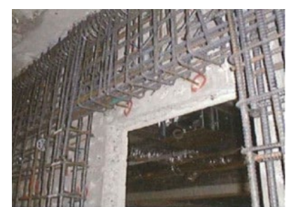
処理場の耐震化（躯体補強）
