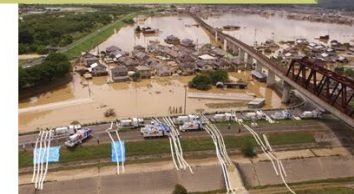
【H30.7月豪雨】 (岡山県倉敷市真備町)
