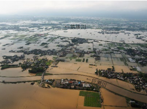
巨瀬川の浸水状況 (福岡県久留米市)
