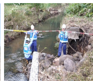
被災状況調査(河川) (石川県輪島市)
