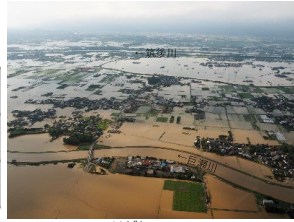
こせがわ 巨瀬川の浸水状況 くろめ (福岡県久留米市)
