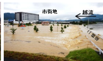
ひじ 肱川の氾濫状況 おおす (愛媛県大洲市)
