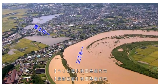
米代川水系米代川5.5K(能代市)付近 (令和7年9月3日あおぞら号撮影)
