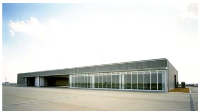
水防センター外観
