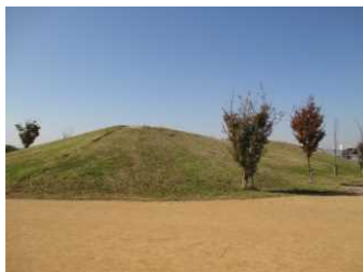
↑広場を兼ねた水防資材の備蓄(備蓄土砂と水防用竹木)
